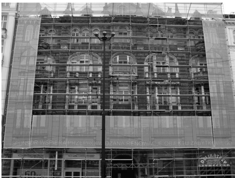
Fot. 5. Sponsor wspiera renowację budynku (Warszawa, Al. Jerolimskie)
